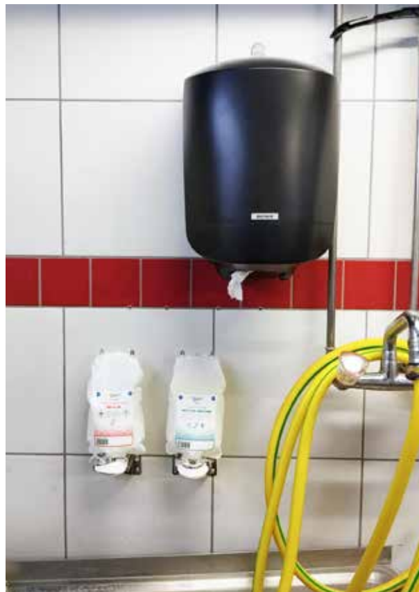
Après le montage
